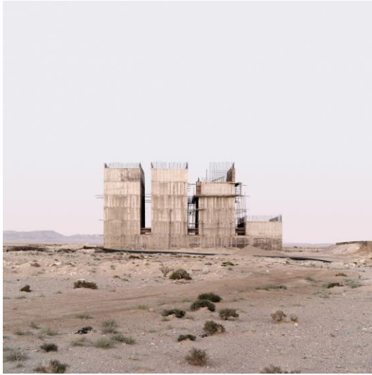
Réservoir d'eau en construction
