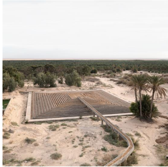
Edifice de refroidissement d'eau thermique (Oasis de Zaouia)
